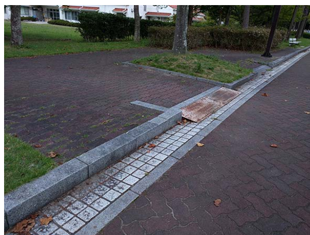
園路のL型側溝にふた掛けをして 移動の連続性を確保した状態
